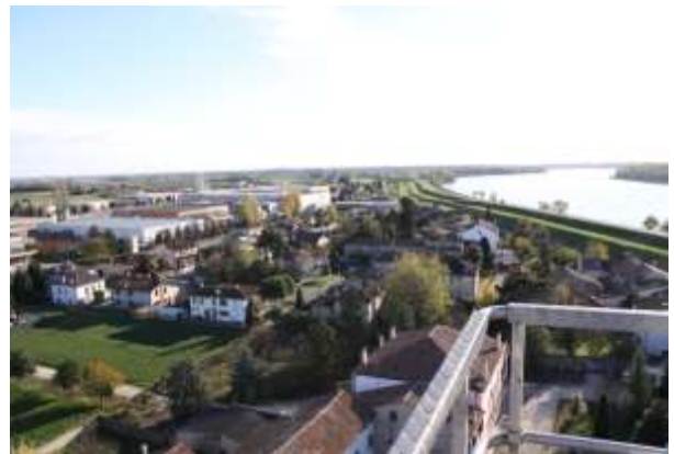
Vista verso Est
